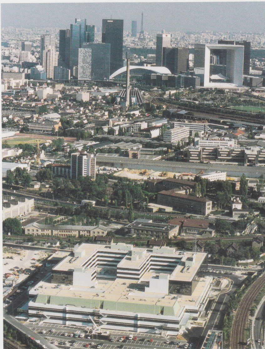
Les nouveaux locaux d'Alcatel Espace aux portes de la Défense.
