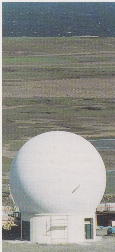
Février 1993 : construction du radôme à Kerguelen.
