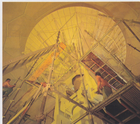
Septembre 1993 : démontage de l'antenne.
