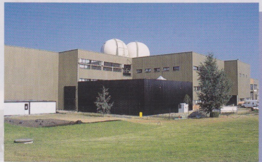
Extension de la salle d'intégration du bâtiment D : livraison prévue mi-novembre, avec des aménagements spécifiques (climatisation, revêtements sols et murs).
