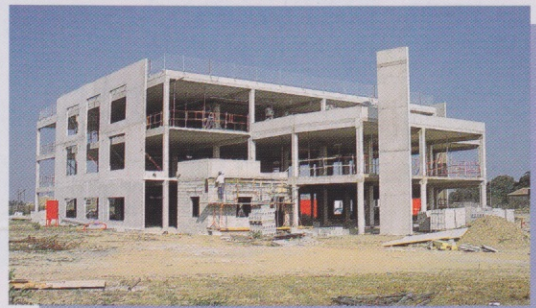
Bâtiment WorldSpace : livraison au premier trimestre 98
