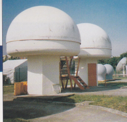
Plots d'intégration station N SYRACUSE II.
